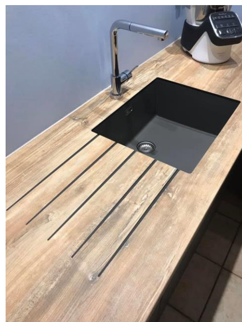
Plan compact 10mm réf. Slavonia cœur noir avec usinage égouttoir et cuve sous plan
