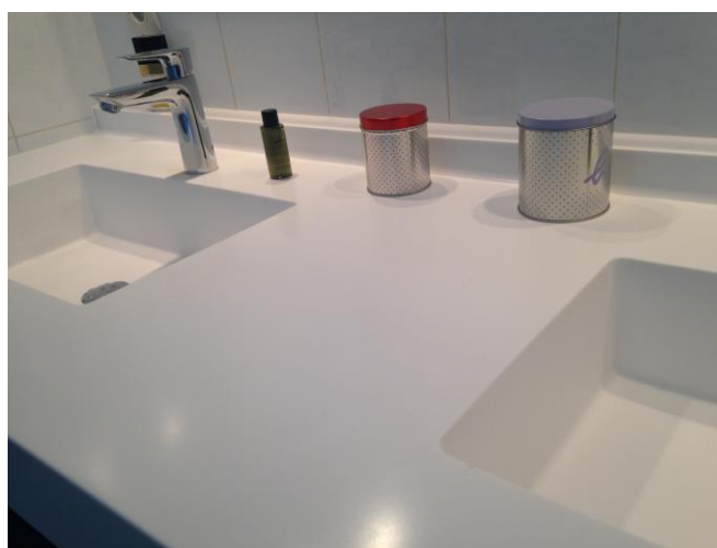
Plan à recouvrement sur mesure avec double vasque en résine de synthèse. Aucun joint apparent.
